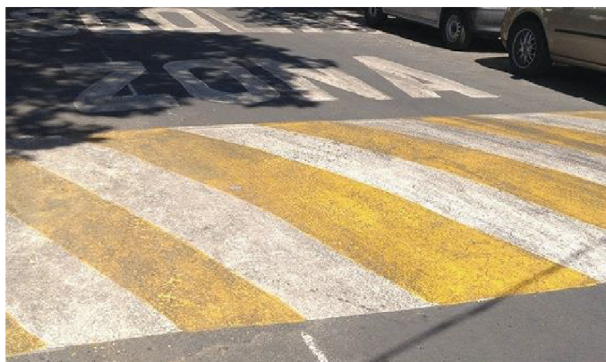
Figura 3.7. Limitator de viteză tip pavaj înălțat.
